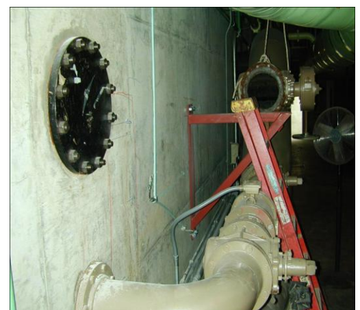
Fukushima Réacteurs à Eau Bouillante – REB Vue de travaux de maintenance zone "Humain"
